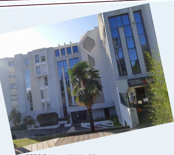
SESSIP Immeuble Le Minotaure
