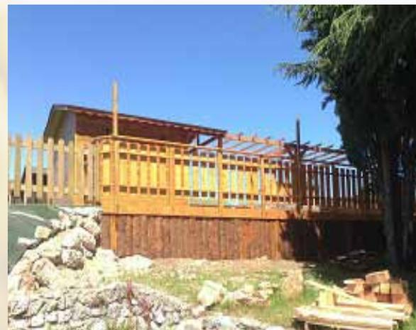
Réalisée par une équipe de 8 ouvriers, la fabrication a débuté par la pose d'une structure destinée à recevoir le plancher. Cette structure a servi de niveau aux autres entreprises intervenantes.
